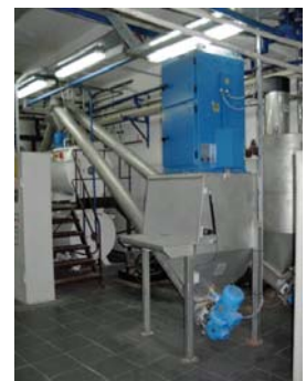
Sackentleerung mit Filter und Dosierschnecke.
